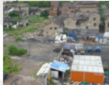
图 2 持续拆迁中的中心区一角 (上海) Pic. 2 One corner of central district under demolition (Shanghai)
